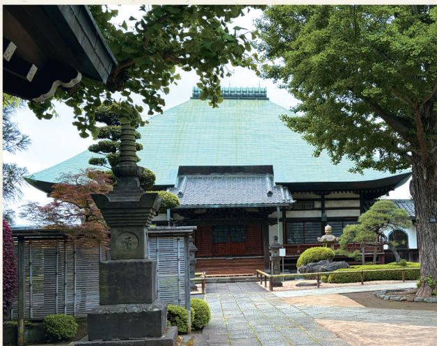
昭和四十八年に復元解体工事が行われた本堂
